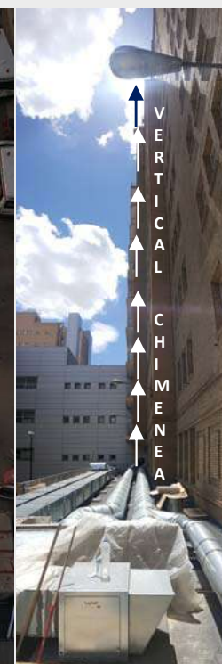
Vista desde P.16 del trazado exterior de chimeneas y conductos Climatización Comedor Público
