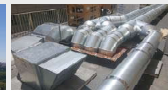
Salida Conductos a Cubierta
