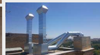
Vista desde P.16 del trazado exterior de chimeneas y conductos Climatización Comedor Público
